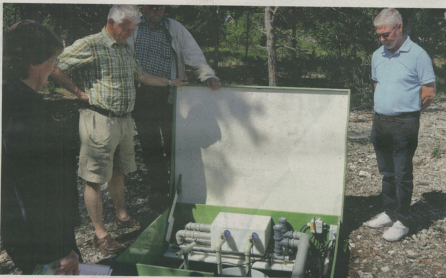
Rent avlopp. Hanna Karlén, Torsten Bäckstrand, Krister Löfgren samt Christer Malmqvist beskådar det sandfilter som renar avloppsvattnet innan det slussas ut i Östersjön.
