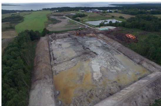
Bevattningsdamm under uppbyggnad. Dammen täcks med gummiduk.
