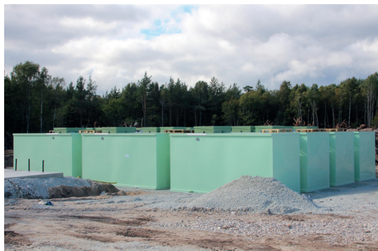
Det modulbyggda reningsverket placeras ut innan det återfylls med massor.
