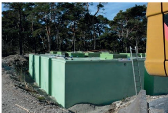
Reningsverket under entreprenaden.
